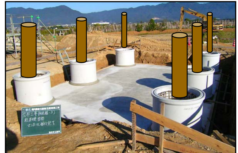
柱を固定する基礎
