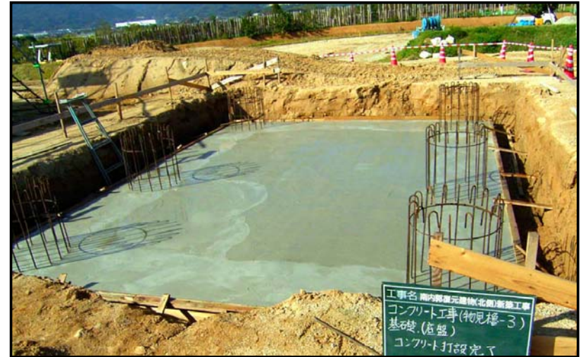
柱を支えるコンクリート基礎
