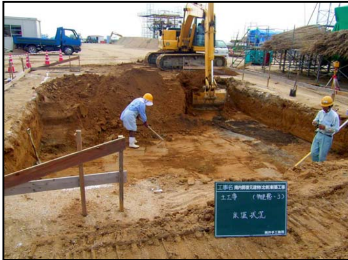
機械による土の掘削
