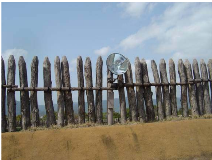
照明は木柵と一体に
